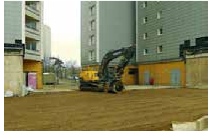
Nach dem Abriss: Der Boden wird planiert, März 2014, Foto: Martin Schönfeld
