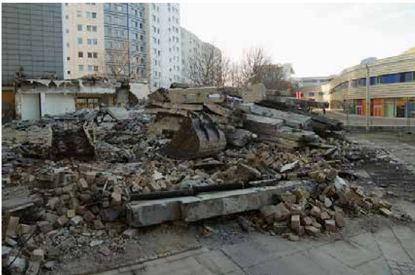
Das Kunsthaus im Abriss, Januar/Februar 2014, Foto: Martin Schönfeld
